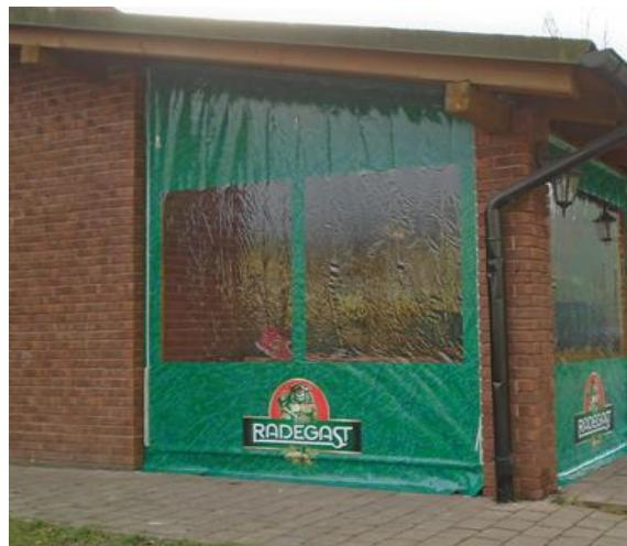
Vzhledem k materiálu, ze kterého se PVC plachty vyrábí, není možné dosáhnout vyrovnání a průhlednosti oken do takové míry, jako by se jednalo o skleněnou plochu. Manipulací se folie krčí, je to standardní jev, na který není možné uplatnit reklamaci. Záruka se vztahuje pouze na mechanické poškození, např. šrámy a oděrky, které je nutno zkontrolovat při převzetí díla.
