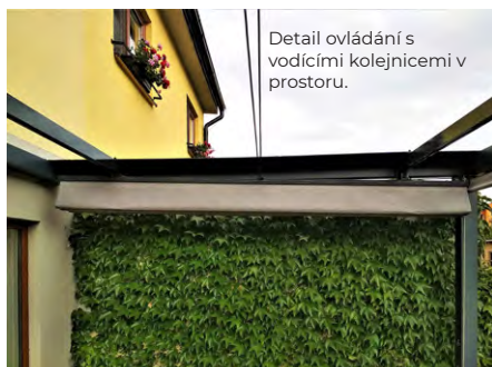
Detail uchycení vodících kolejnic
