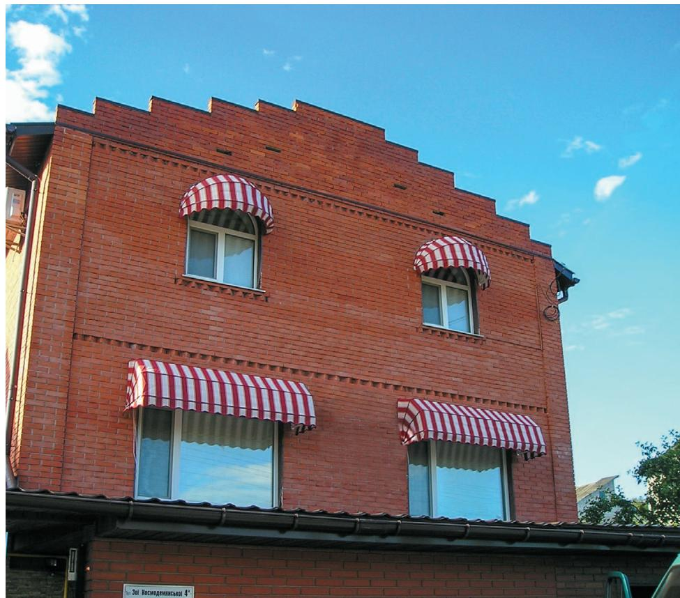
Košová markýza dokáže svým klasickým tvarem vytvořit nezaměnitelný vzhled budov. Slouží jako vysoce funkční reklamní prvek obchodů, hotelů a restaurací. Pevná konstrukce markýzy je vyrobena z hliníkových profilů s potahem z vrstveného PVC. Na výběr je celá řada tvarů.
